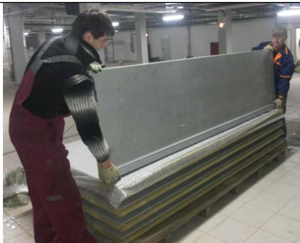
Створка ворот состоит из панелей (5), которые пронумерованы. Количество панелей зависит от ширины проема. Опционально в любой из панелей на производстве может быть установлен лючок 150x150 мм.
