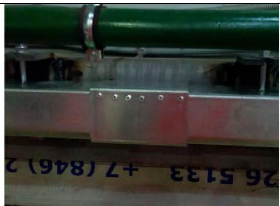
После установки всех кронштейнов подвешиваются рельсы, которые выступают на 100 мм за проём на стороне примыкания (закрытия).
