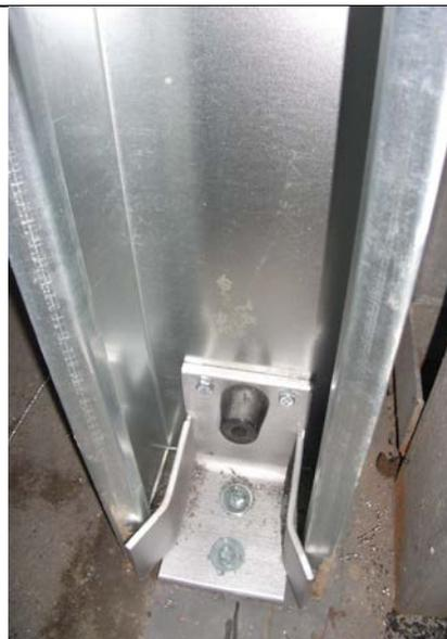
Для возможности регулировки по высоте карман примыкания (12) поставляется с избыточной высотой. Измерьте расстояние от верхней кромки внешнего рельса до пола и, если необходимо, укоротите карман примыкания снизу. Боковые стенки кармана примыкания должны прилегать к внешнему рельсу.
